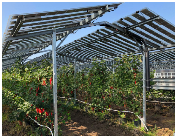
Figuur 15. Voorbeeld energielandschap: combinatie van energieopwek en landbouw door Agri-PV (bron onbekend)
